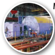
**Модернизация турбогенератора ПТ-80/100-130/13 ст. №3 в энергетическом комплексе (НиГРЭС) АО «Волга».**
