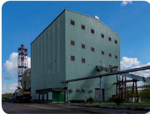
С 2008 года все кородревесные отходы совместно с осадками очистных сооружений сжигаются с получением тепловой энергии в мощном котле, а образующаяся в результате сжигания отходов зола охлаждается и утилизируется, не представляя угрозы загрязнения окружающей среды.
