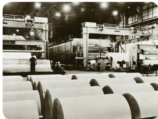
В 1960 годы началась коренная реконструкция и расширение предприятия: запущены в эксплуатацию комплексы шестой и седьмой бумагоделательных машин, новый древесномассный завод и склад готовой продукции.
