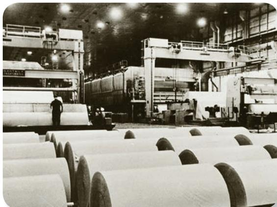
В 1960 годы началась коренная реконструкция и расширение предприятия: запущены в эксплуатацию комплексы шестой и седьмой бумагоделательных машин, новый древесномассный завод, очистной цех и склад готовой продукции.
