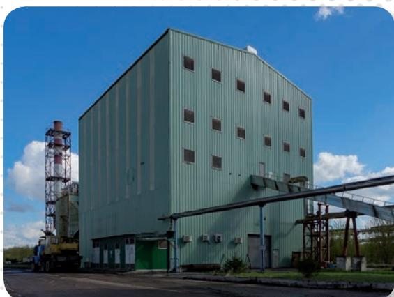
С 2008 года все кородревесные отходы совместно с осадками очистных сооружений сжигаются с получением тепловой энергии в мощном котле, а образующаяся в результате сжигания отходов зола охлаждается и утилизируется, не представляя угрозы загрязнения окружающей среды.
